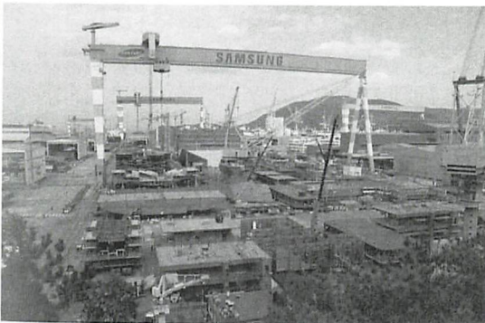
サムソン重工のドックで建造中のFPSO(石油生産貯蔵設備)
